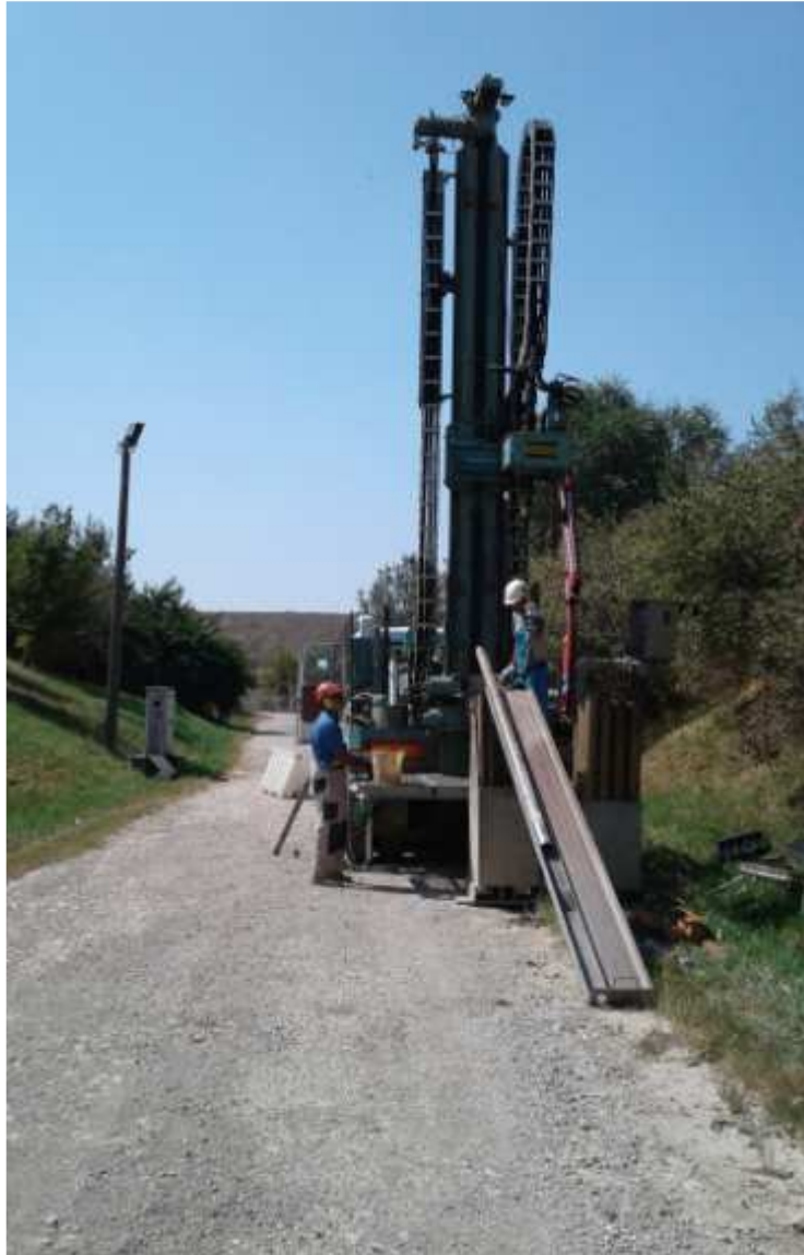
Fig.19. Sonda utilizzata in sito per l'esecuzione delle perforazioni.
